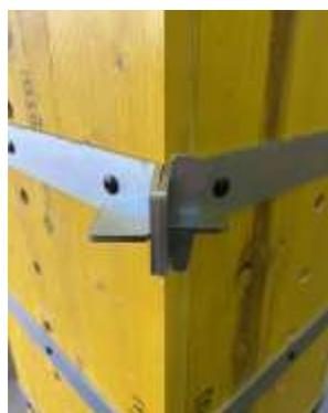
3. Fixer les deux parties grâce aux armatures et aux clavettes et chevalets
