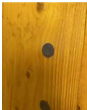
2 . Passer les gaines électriques aux emplacements souhaité et bouchés les trous non utilisés avec les bouchons de coffrage à l'aide d'un marteau
