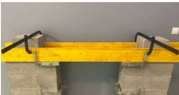
5 . Fixer les panneaux de coffrage à l'aide de serre-joint
