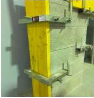
7. Aide à coffrage vertical "Bloc à bancher" ou autres
