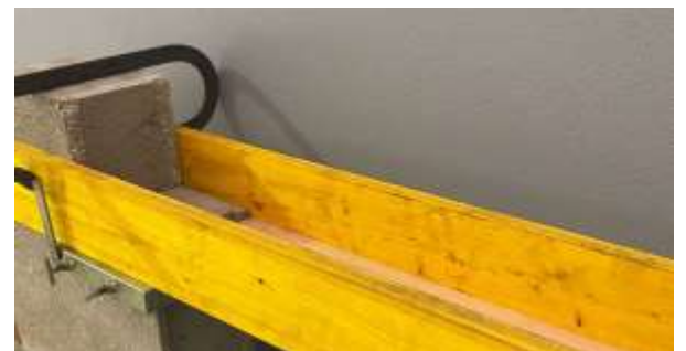
6 . Le linteau, poutre ou bloc est prêt à être coulé
