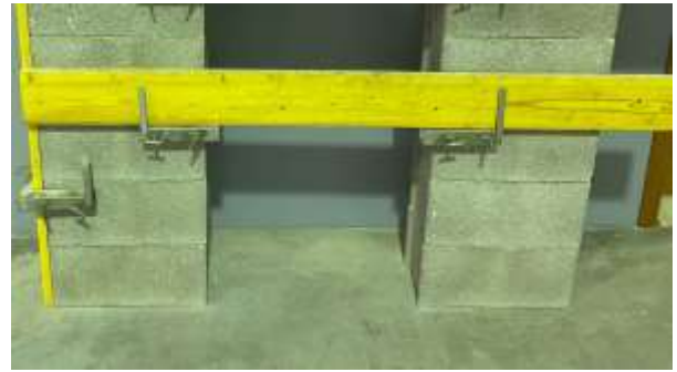
8. Utilisation en garde-corps pour les ouverture d'une constructions
