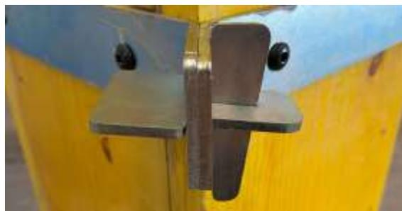
2 . Fixer les deux parties grâce aux armatures et aux clavettes et chevalets
