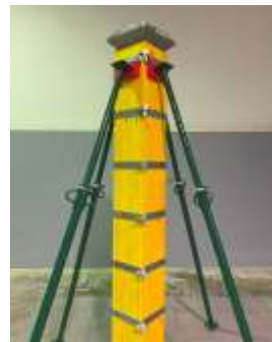
4 . Le Poteau SR est prêt à être coulé
