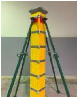
3 . Stabiliser le Poteau avec des étais grâce à l'emplacement prévu pour
