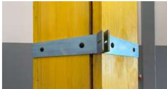
1 . Assembler les deux parties du Poteau SR
